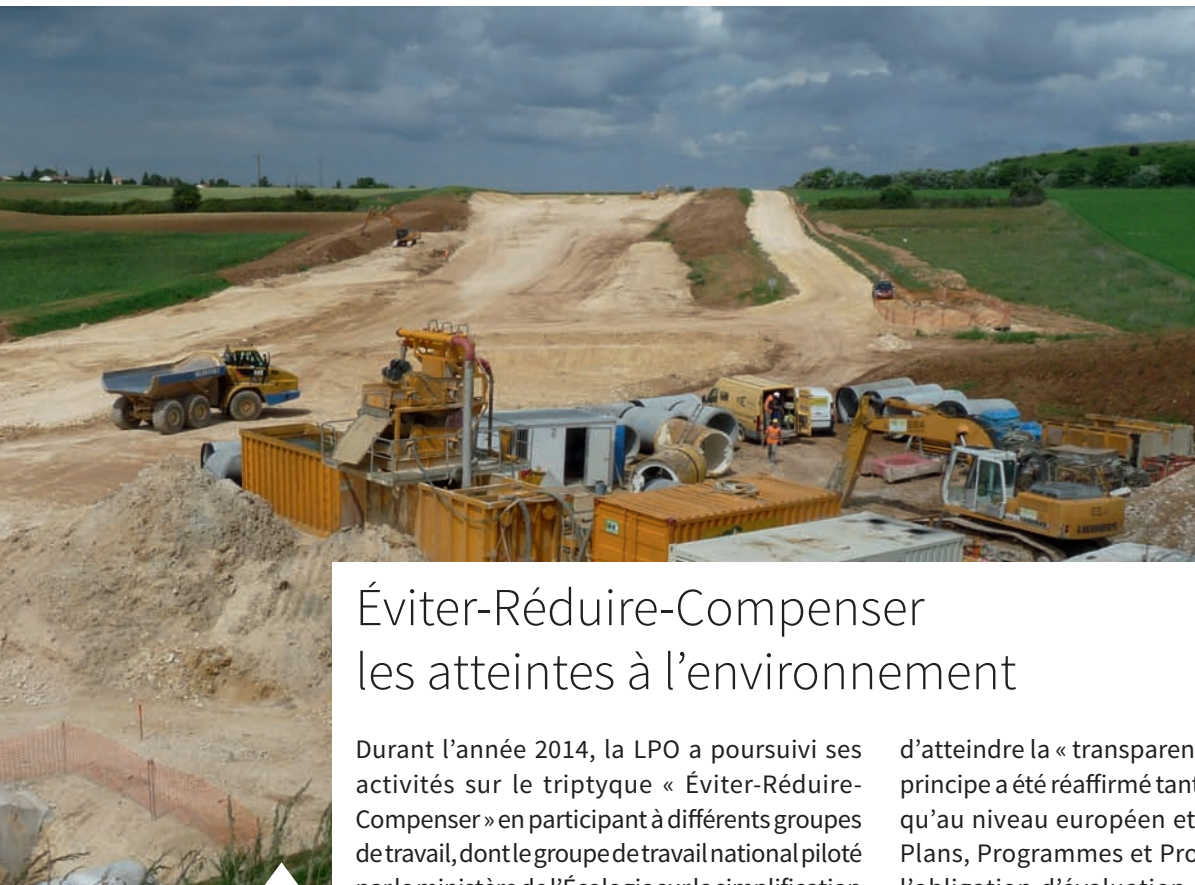
Chantier de la ligne LGV © Sophie Gauthier
