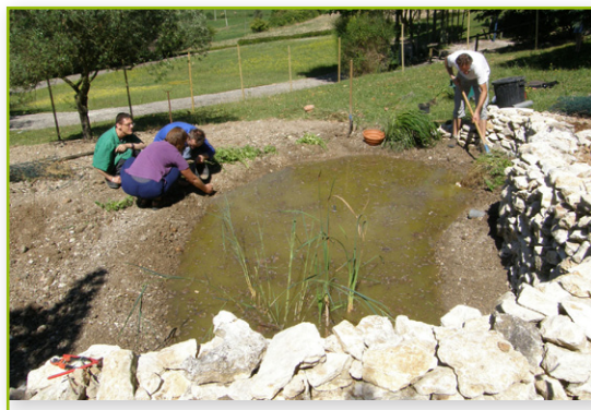
Construction mare pédagogique © J. ROI
