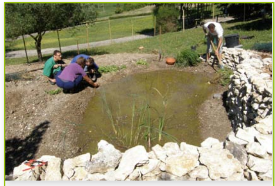
Construction mare pédagogique © J. ROI
