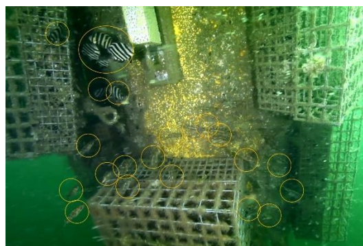
Pieu équipé de Biohut
