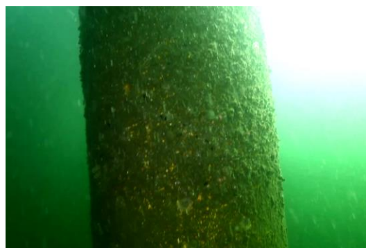
Pieu non équipé
