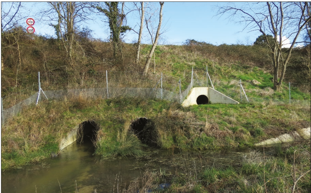
Photo n°36 : Écoduc de type IIIe sur l'A10, à proximité de 2 buses hydrauliques. (© LPO France, VINCI Autoroutes).
