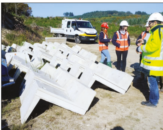
Photos n°22 : Stockage d'éléments préfabriqués d'une banquette. (© VINCI Autoroutes).
