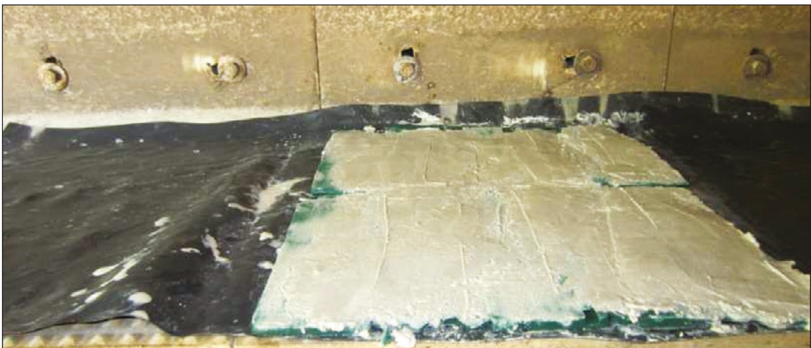
Photo n°70 : Disposition d'un piège à traces sur un encorbellement de l'A62. (@Cistude Nature).
