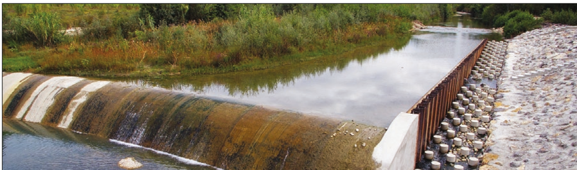
Photo n°86 : Vue du seuil, de la passe aquatique et de l'enrochement aménagés. (© P. Roche, ONEMA).
