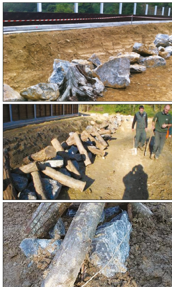
Photos n°12 : Réalisation d'andains ; on note le passage du câble sur la photo au centre. (@VINCI Autoroutes).
