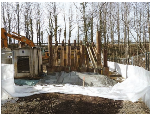
Photos n°20 : Plateforme de travail sur le chantier de l'écoduc de la Marguerite (A10) avec groupe électrogène sur un double fond bâché et géotextile conforme aux recommandations (gauche). À noter la proximité avec le cours d'eau et la conservation de certains arbres sur la zone (droite). (© VINCI Autoroutes).
