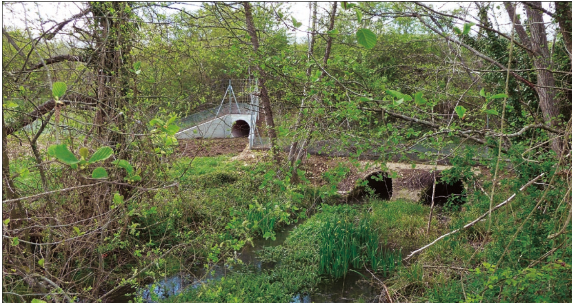
Photo n°5 : Écoduc à proximité d'un ouvrage hydraulique. (© VINCI Autoroutes)
