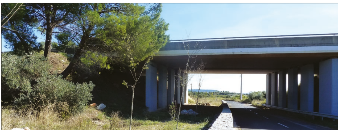
Photo n°64 : Passage mixte inférieur sur l'A9. (©VINCI Autoroutes).
