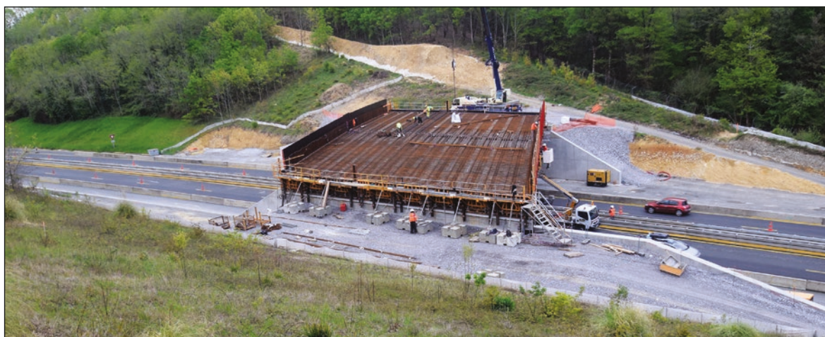
Photos n°16 : Chantiers d'écoponts ci-dessus et sur la page suivante. (© VINCI Autoroutes).
