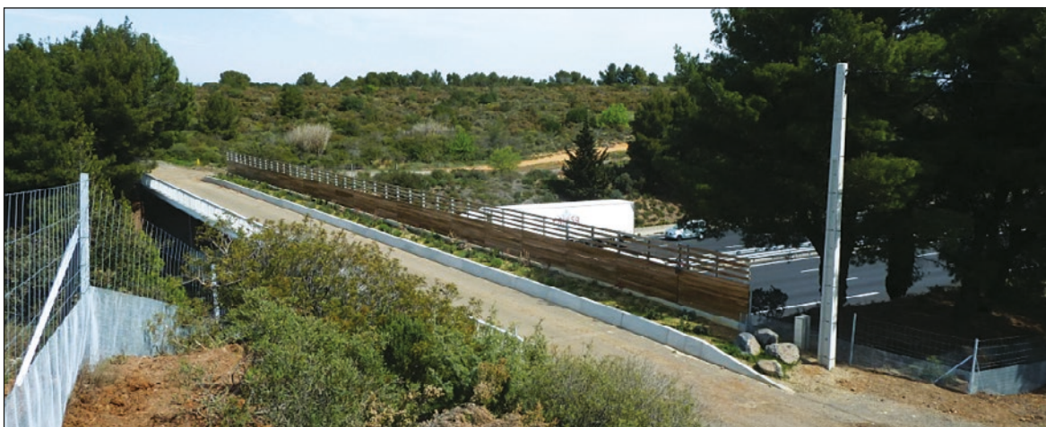
Photo n°63 : Passage mixte supérieur sur l'A9. (©VINCI Autoroutes).
