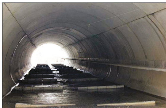
Photo n°23 : Barrettes équipées d'un encorbellement dans un ouvrage hydraulique. (© Freyssinet)
