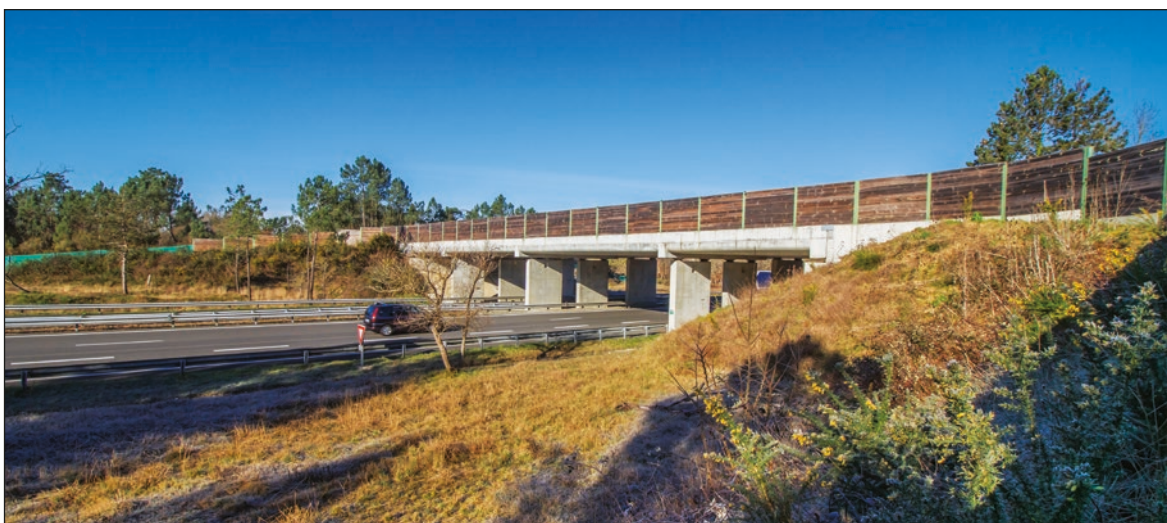
Photo n°9 : Vue d'ensemble d'un écopont avec ses panneaux occultant. (©A.Orseau-LPO France, VINCI Autoroutes)
