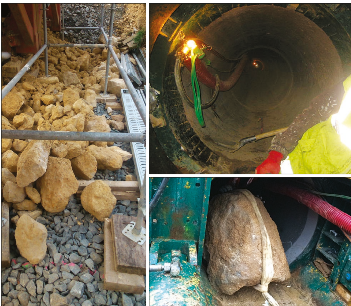
Photos n°17 : Technique de la tarière avec au 1 er plan certains blocs de diamètre limite (gauche) sur A11, technique à front ouvert (haut, droite) et bloc massif excavé avec cette technique (bas, droite) sur A83. (©VINCI Autoroutes).
