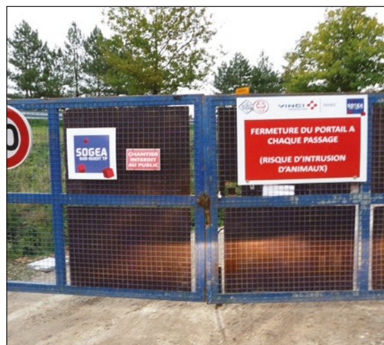
Photo n°15 : Dispositif de portail de chantier avec panneau indiquant la fermeture obligatoire. (© VINCI Autoroutes).
