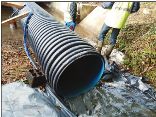
Photo n°28 : Bâchage anti-érosif en sortie de la buse de dérivation. (© VINCI Autoroutes).
