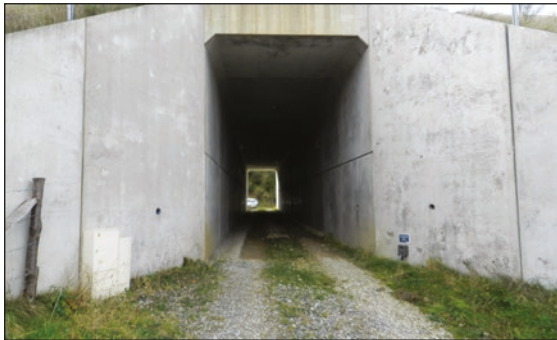
Photo n°67 : Passage inférieur non dédié sous l'A89. (©FRAPNA Loire).
