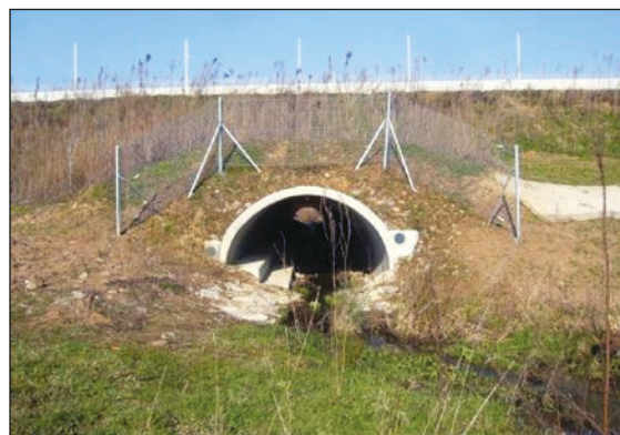
Photo n°51 : Banquette préfabriquée sur l'A89. (©EGIS).
