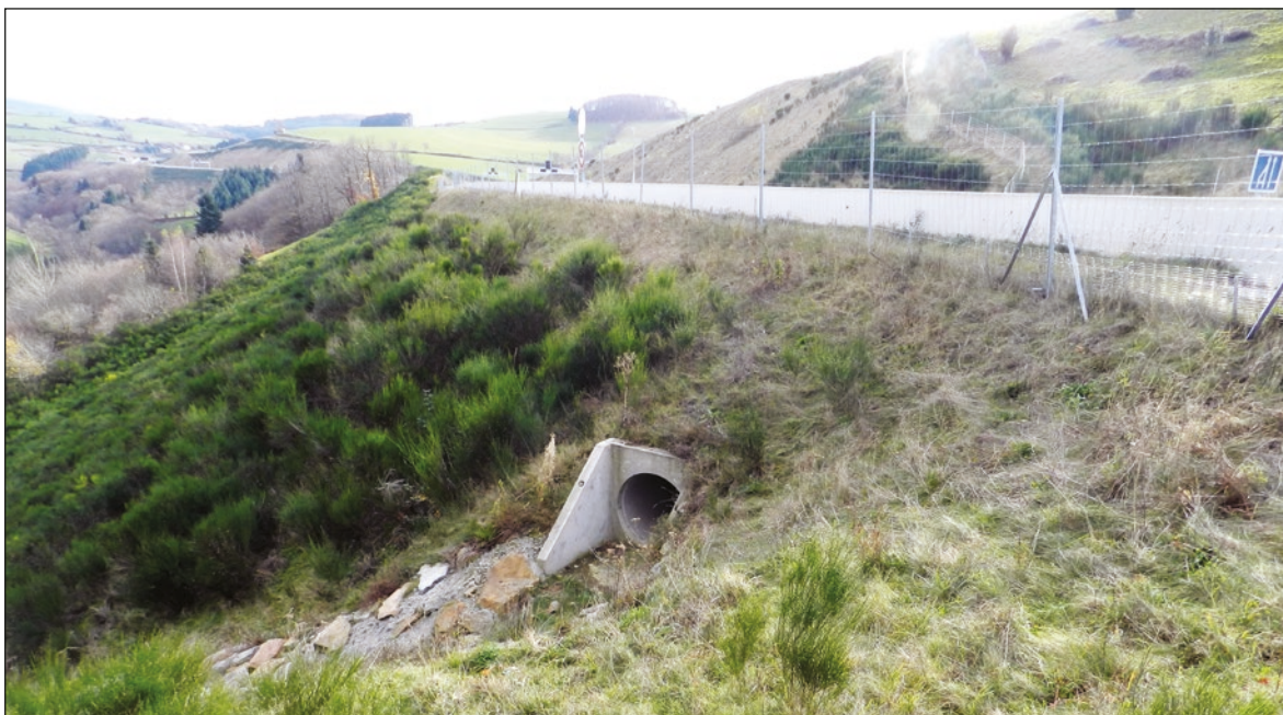
Photo n°68 : Ouvrage hydraulique non dédié sur l'A89. (©FRAPNA Loire).
