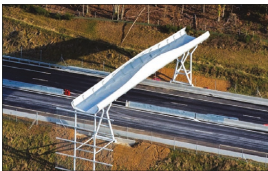
Photo n°6 : Chiroduc sur l'A89. (© VINCI Autoroutes)
