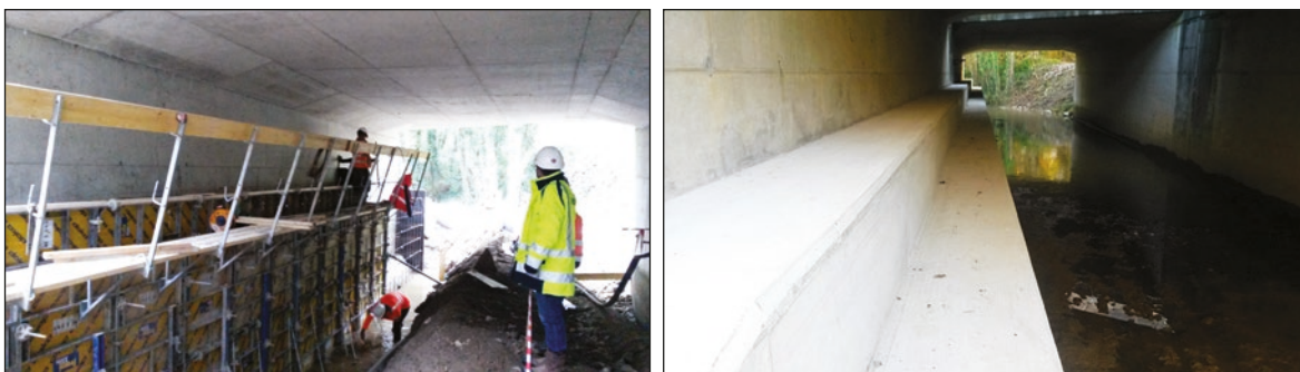
Photos n°25 : Coffrage d'une banquette double marche (gauche) et vue de la banquette achevée à l'intérieur de l'OH (droite). (© VINCI Autoroutes).
