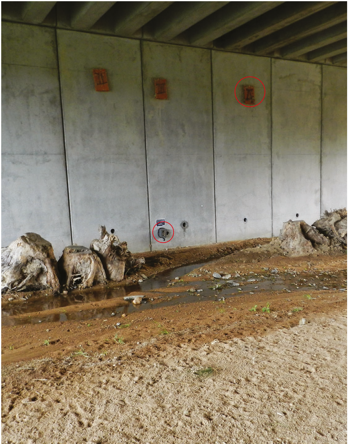
Photo n°35 : Piège photographique dans un PIGF* de l'A89 et gîtes à chiroptères. (©FRAPNA Loire, VINCI Autoroutes).
