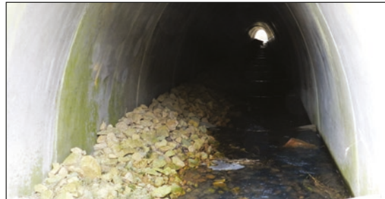
Photo n°49 : Enrochement sur l'A89. (©FRAPNA Loire).
