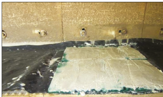
Photo n°32 : Piège à traces sur un encoffrement de l'A62. (@Cistude Nature).
