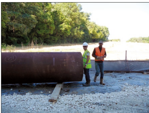
Photos n°21 : Stockage conforme sur géotextile avec buse sur cales en bois. (© VINCI Autoroutes).
