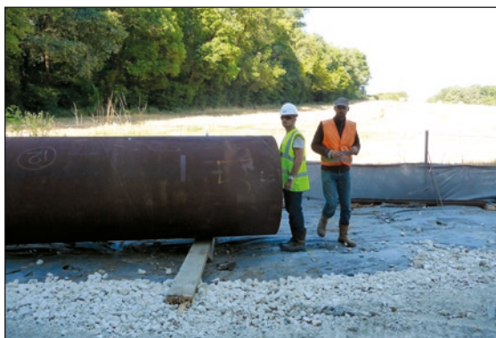
Photos n°33 : Stockage conforme sur géotextile avec buse sur cales en bois. (© VINCI Autoroutes).
