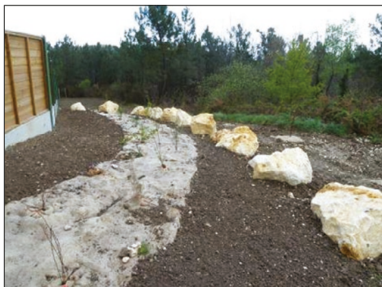
Photo n°39 : Alignement de blocs anti-intrusion. (© VINCI Autoroutes).
