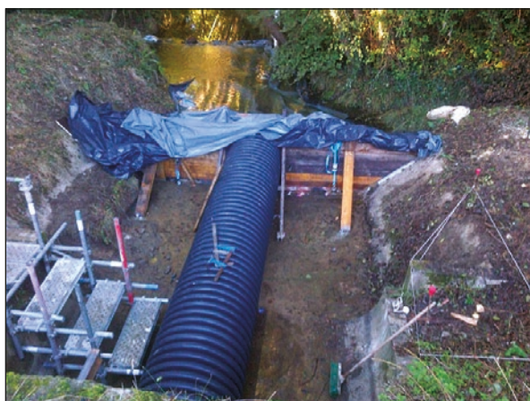
Photos n°46 : Dérivation par busage et batardeaux (on note la matérialisation du raccord à la berge sur la photo), pêche électrique préalable réalisée par une FDPPMA (de gauche à droite). (© VINCI Autoroutes).
