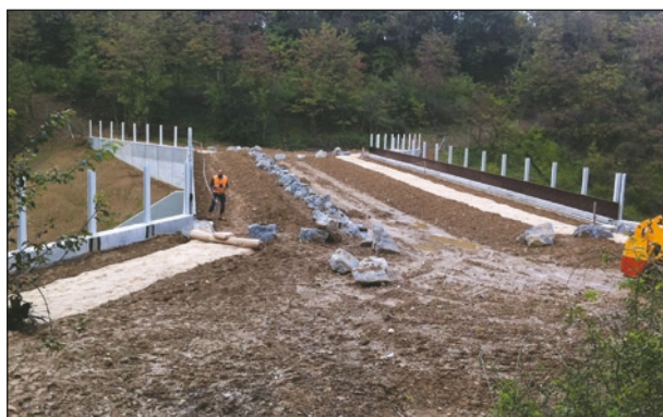
Photos n°6 : Écopont en phase chantier (à gauche), puis, trois années après sa mise en service (à droite). (© VINCI Autoroutes)
