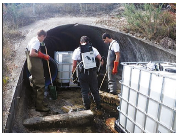
Photos n°46 : Dérivation par busage et batardeaux (on note la matérialisation du raccord à la berge sur la photo), pêche électrique préalable réalisée par une FDPPMA (de gauche à droite). (© VINCI Autoroutes).
