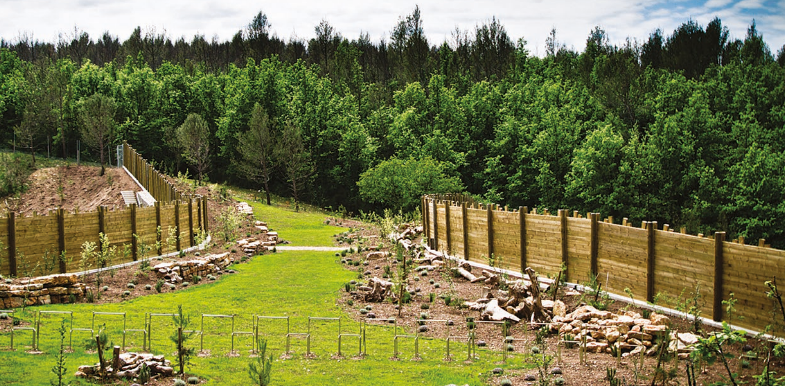
Photo n°5 : Écopont en service, aménagé pour l'ensemble des groupes faunistiques (petite*, moyenne* et grande faune*). (© Olya, VINCI Autoroutes)
