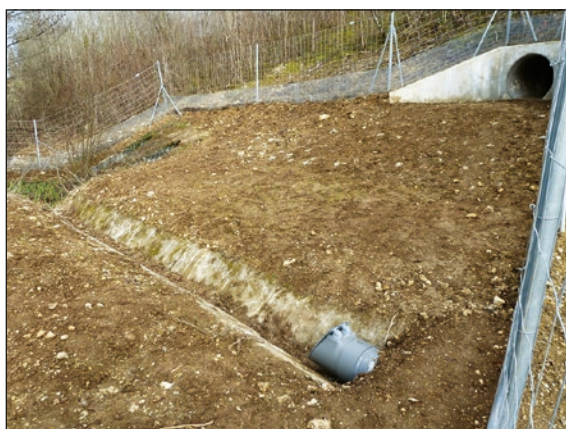
Photo n°31 : Dispositif de type clapet adapté dans certains cas uniquement (clôture franchissant un fossé). (© VINCI Autoroutes).
