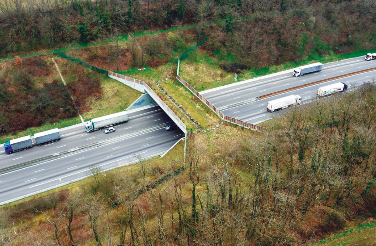
Photo n°27 : Écopont dans la vallée du Rhône. (© Alterra, VINCI Autoroutes).
