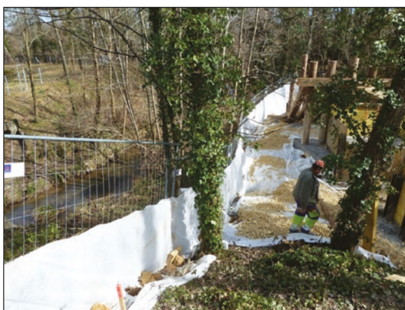
Photos n°32 : Plateforme de travail sur le chantier de l'Écoduc de la Marguerite (A10) avec groupe électrogène sur un double fond bâché et géotextile conforme aux recommandations (photo de gauche). A noter la proximité avec le cours d'eau et la conservation de certains arbres sur la zone (photo de droite). (© VINCI Autoroutes).
