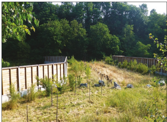
Photo n°35 : Écopont. (@ VINCI Autoroutes).
