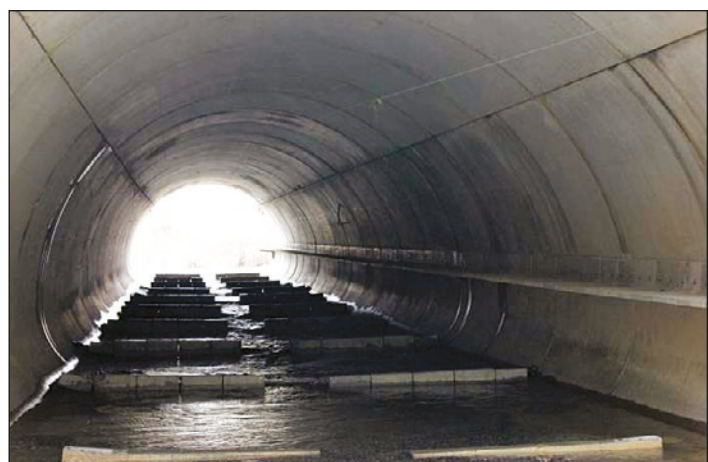
Photo n°42 : Barrettes équipées d'un encorbellement dans un ouvrage hydraulique. (© Freyssinet)
