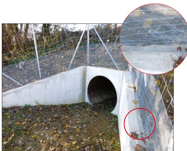
Photos n°30 : Repositionnement semi enterré du grillage renforcé (photo de gauche), jointure au mortier du grillage autour de la tête (photo de droite). (© VINCI Autoroutes).
