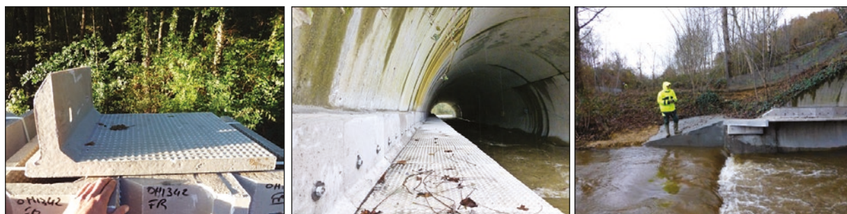
Photos n°43 : Encorbellement en béton polymère, encorbellement achevé dans l'OH et raccordement offrant une possibilité de passage depuis le pied et le haut de berge et ne générant pas un point dur à l'écoulement (de gauche à droite). (© VINCI Autoroutes).
