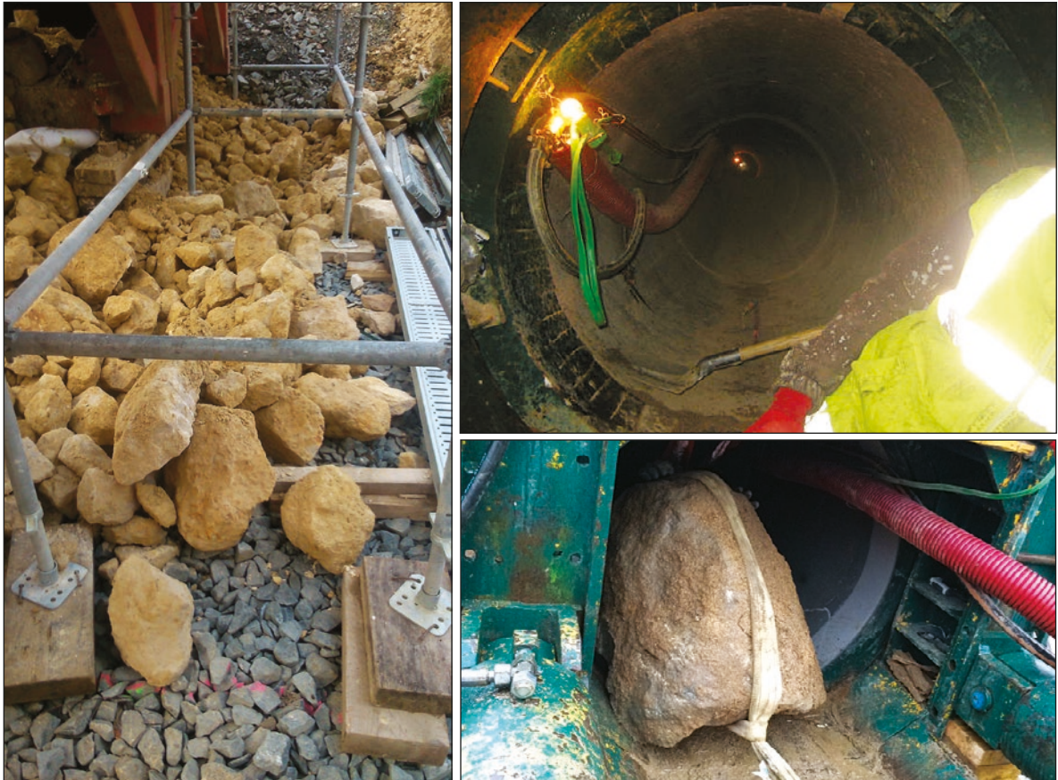
Photos n°29 : Technique de la tarière avec au 1 er plan certains blocs de diamètre limite (gauche) sur A11, technique à front ouvert (haut, droite) et bloc massif excavé avec cette technique (bas, droite (A83)). (© VINCI Autoroutes).
