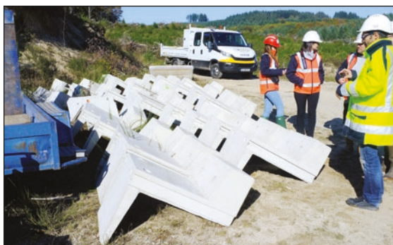
Photos n°34 : Stockage d'éléments préfabriqués d'une banquette. (© VINCI Autoroutes).
