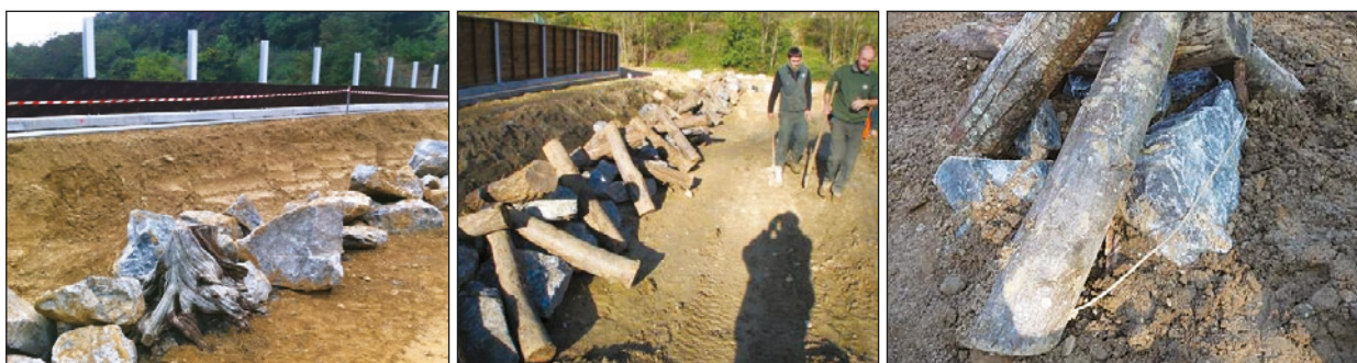
Photos n°38 : Réalisation d'andains ; on note le passage du câble sur la photo de droite (de gauche à droite). (© VINCI Autoroutes).
