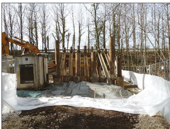
Photos n°32 : Plateforme de travail sur le chantier de l'Écoduc de la Marguerite (A10) avec groupe électrogène sur un double fond bâché et géotextile conforme aux recommandations (photo de gauche). A noter la proximité avec le cours d'eau et la conservation de certains arbres sur la zone (photo de droite). (© VINCI Autoroutes).
