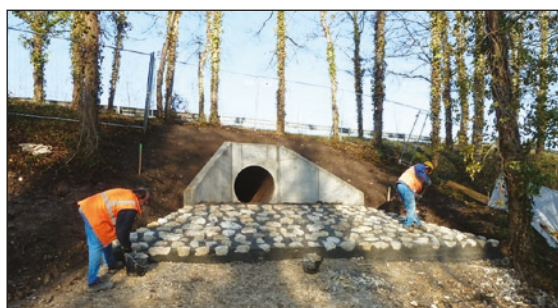
Photo n°28 : Réalisation d'une rampe maçonnée avant recouvrement de terre. (© VINCI Autoroutes).
