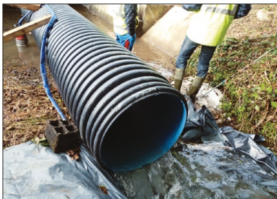
Photo n°48 : Bâchage anti-érosif en sortie de la buse de dérivation. (© VINCI Autoroutes).
