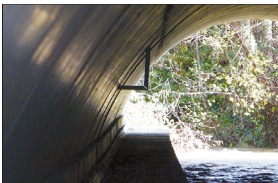
Photo n°45 : Fixation du « L » en vue du suivi écologique post-aménagement. (© VINCI Autoroutes).
