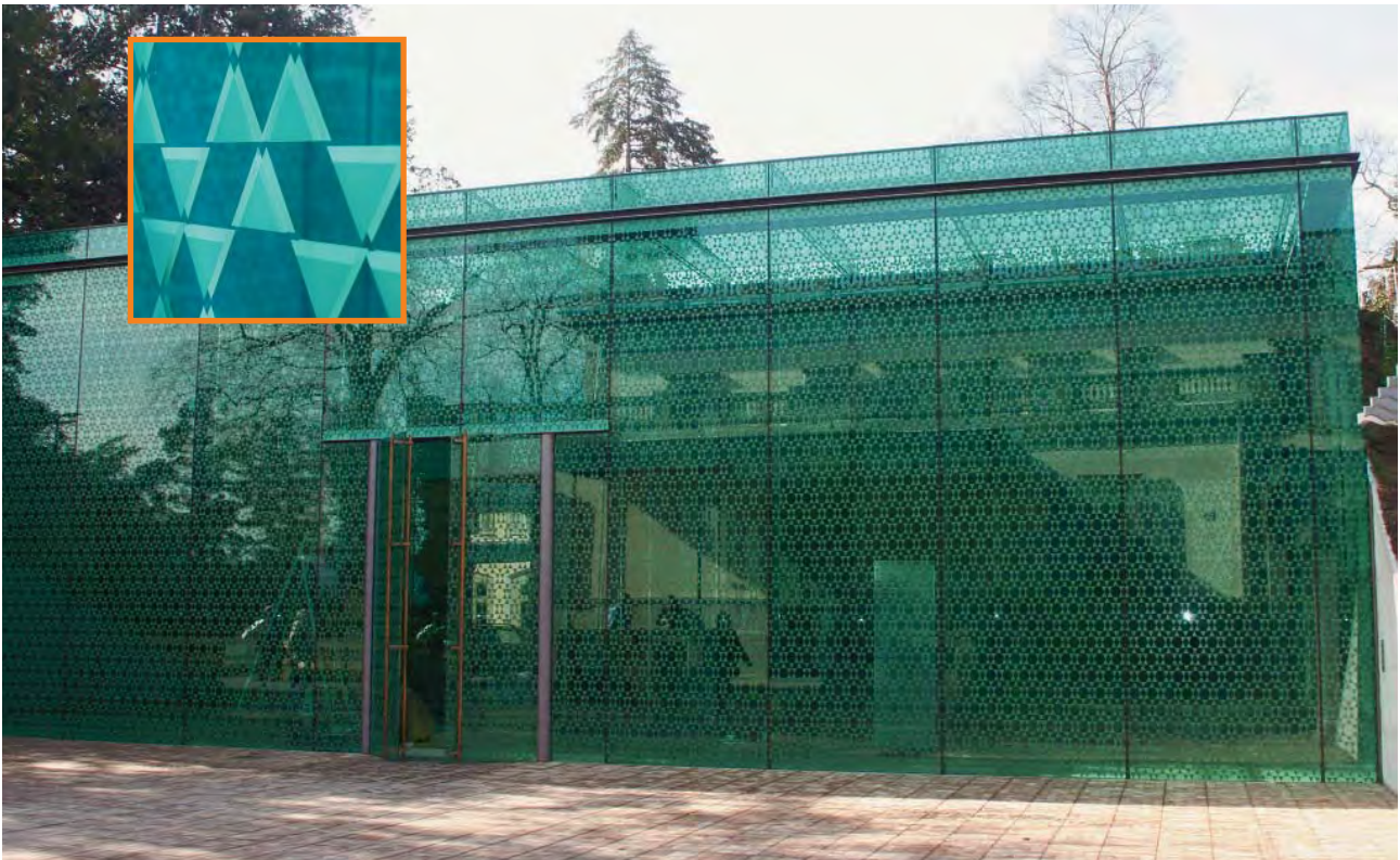
Cette nouvelle annexe du Musée Rietberg de Zurich se situe au milieu du parc. Pour différentes raisons, dont la protection des oiseaux, elle a entièrement été réalisée avec un verre imprimé et a été appelée «Emeraude». Un vrai bijou !
