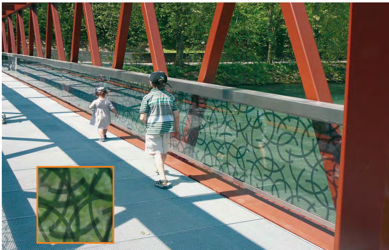
C'est finalement ce décor de segments de cercles semi-transparent qui a été réalisé. Le résultat est élégant et léger. Pour l'oiseau qui arrive en vol, ce décor apparaîtra comme une « cotte de mailles » et sera probablement bien visible pour lui.
