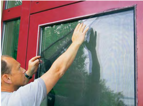
La fixation d'une moustiquaire à l'extérieur de la vitre réduit fortement les réflexions.
