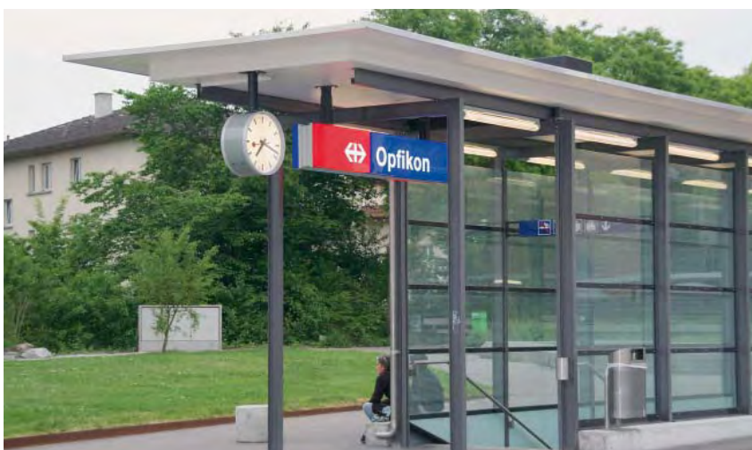
Cet arrêt de train de la région zurichoise a été équipé d'un verre entièrement recouvert du nom du lieu. Une protection discrète et efficace !
