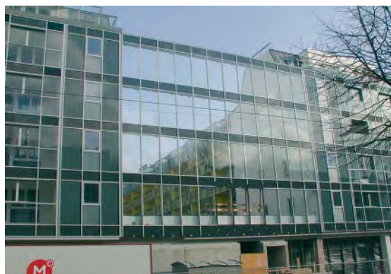
Paroi antibruit et coupe-vent entre deux bâtiments
