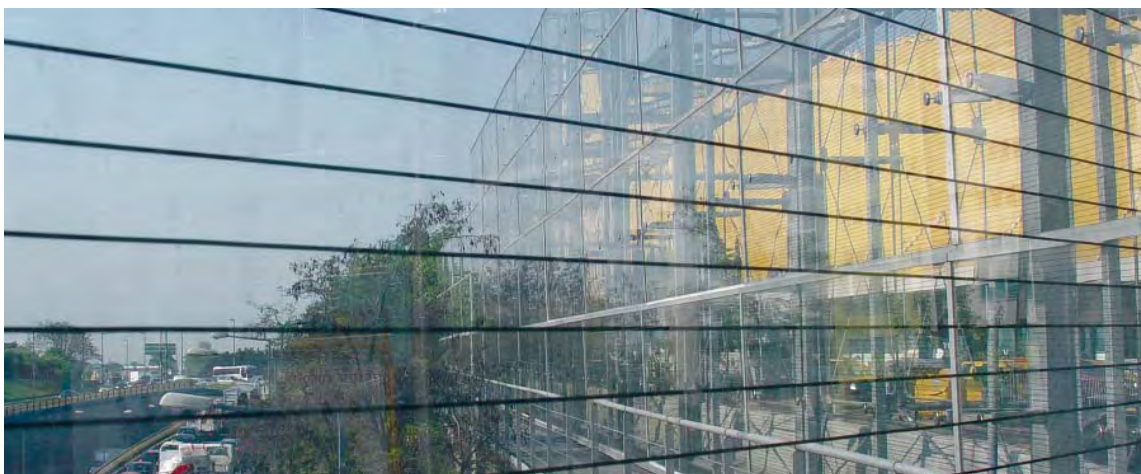
Des lignes noires horizontales d'une épaisseur de 2 mm avec un espace de 28 mm ont obtenus, contre toute attente, de bons résultats en laboratoire. Lorsque la visibilité doit rester maximale, cela pourrait être une bonne solution.
