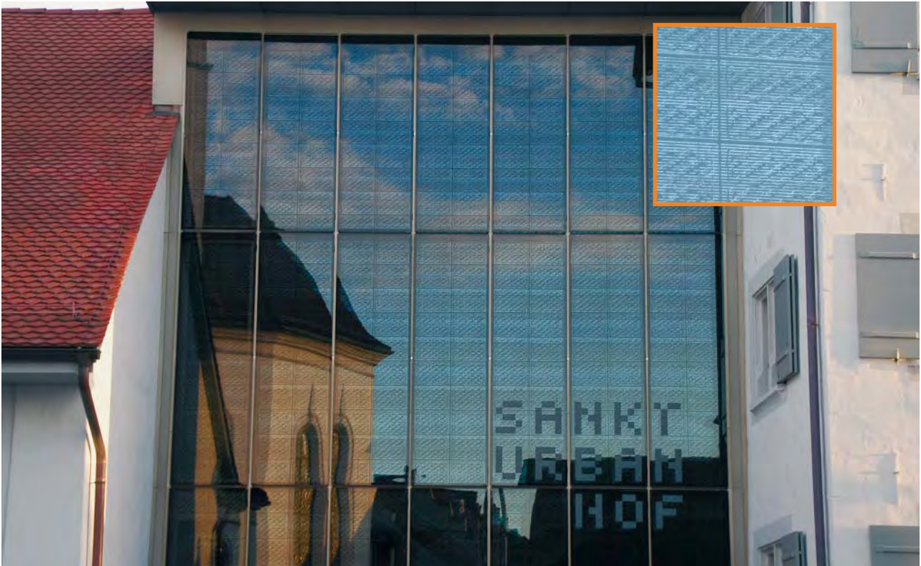
Nouvelle aile qui relie deux bâtiments historiques. Ce type de verre est fortement réfléchissant, mais la surface est rendue visible par la trame qui la recouvre et par l'inscription.
