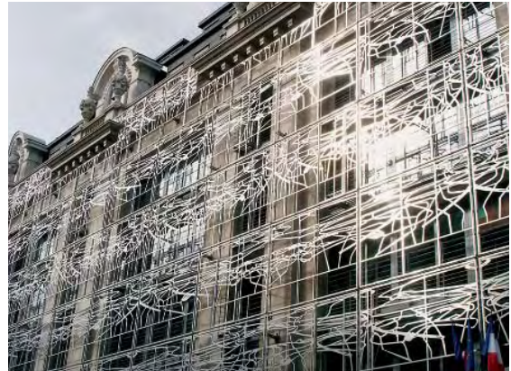
Structure grillagée au ministère de la culture à Paris: art architectural et protection des oiseaux.
