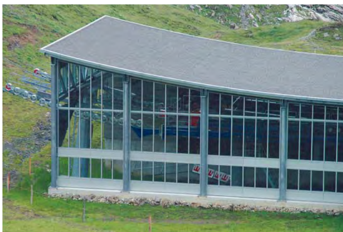
Station de télécabine à trois côtés vitrés. Lors d'un retour tardif de la neige, les oiseaux se sont réfugiés dans le bâtiment et sont entrés en collision avec le verre souvent depuis l'intérieur.
