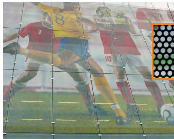
On peut couvrir des façades entières avec de grands films publicitaires. Ils sont en général perforés et permettent donc dans une certaine mesure de voir à travers.
