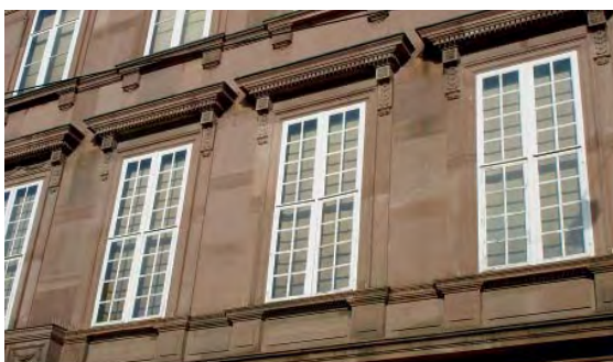
L'emploi de fenêtres à croisillons lors de rénovations n'est pas seulement utile du point de vue de la protection des monuments.
