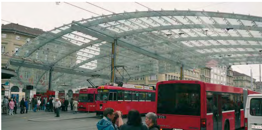
De tels toits en verre sont en général peu problématiques. Un léger danger peut subsister sur les côtés qui sont plus inclinés. Grâce à un décor de points, qui en plus offre aux passants une certaine protection contre l'éblouissement, ce danger est également écarté.
