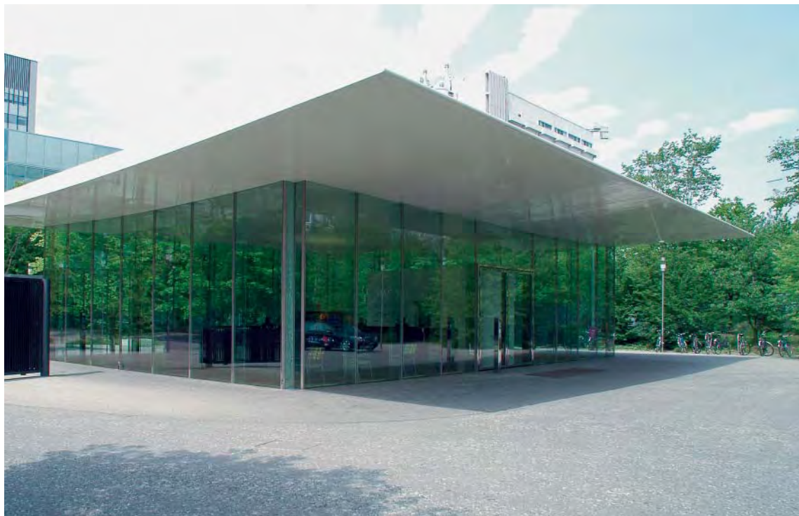
Bâtiment d'accueil d'une grande entreprise. Le lien optique entre la construction en verre et l'environnement est très dangereux pour les oiseaux.
