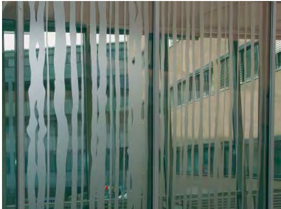
Ce décor de lignes mates («crystall») a obtenu de bons résultats lors de tests.
