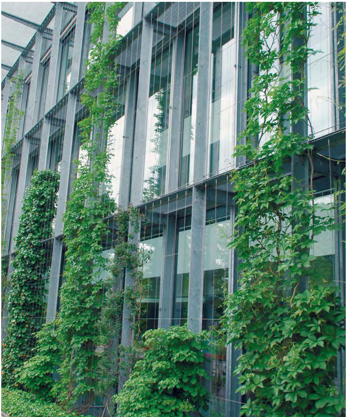
Cette façade végétalisée est une réussite: la distance par rapport aux vitres est faible et le treillis qui partage la façade horizontalement et verticalement devrait être bien visible pour les oiseaux ce qui offre une protection sur une bonne partie de la surface.
