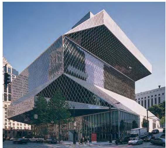
Façade OKATECH finement structurée de la bibliothèque centrale de Seattle. Les réflexions sont ici aussi fortement atténuées.
