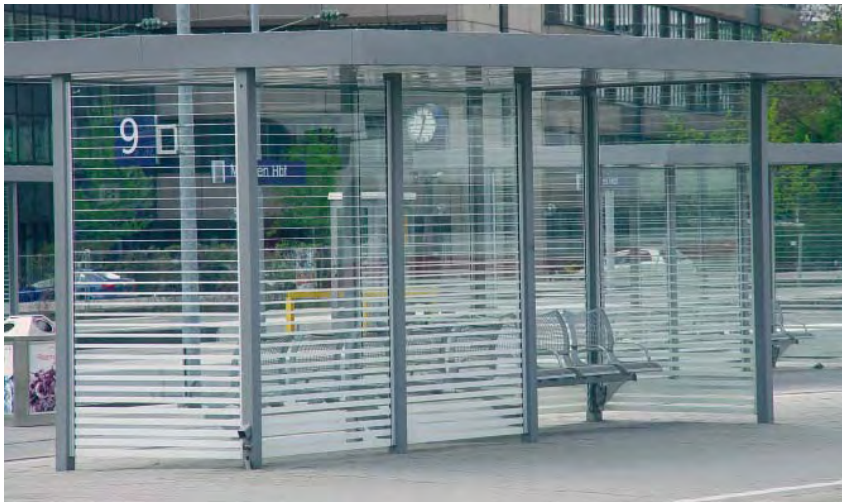
Les abribus, de petites parois antibruit ou coupe-vent, des balustrades de balcons, etc. peuvent assez facilement être décorés de bandes horizontales ou verticales après la construction. Cet objet-ci à Munich a été pourvu dès le départ d'un verre sérigraphié.
