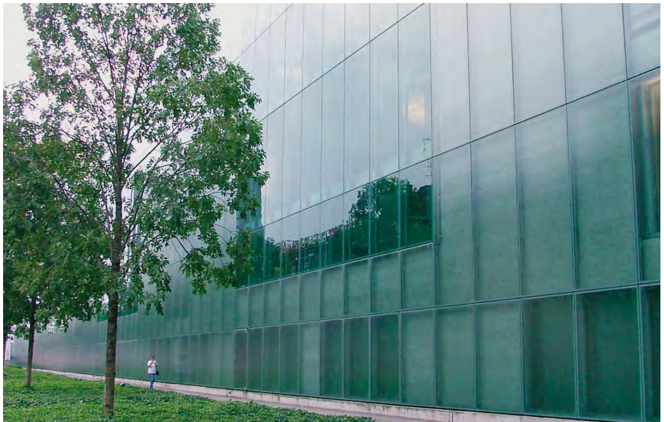
Ces plantations sont très malheureuses, car beaucoup d'arbres se situent juste devant des parties du bâtiment fortement réfléchissantes. En un seul automne, plusieurs centaines de mésanges noires ont trouvé la mort à cet endroit. Cette barrière placée en travers de leur route de migration a empêché la poursuite de leur voyage. Les reflets des arbres leur ont fait croire à un passage possible.
