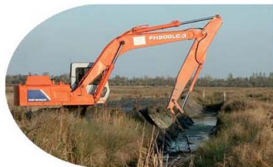
Fossé en cours de curage avec dépôt des boues sur le bord (marais de Voutron - Charente-Maritime)
