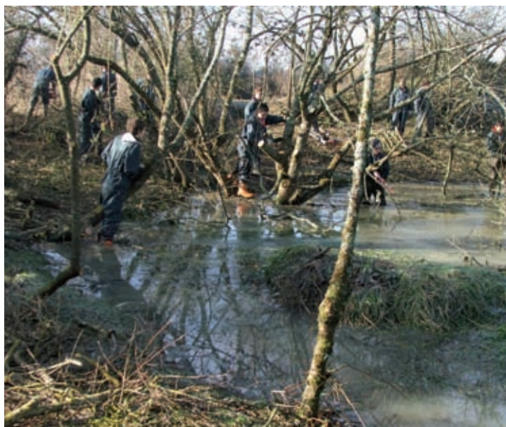
Travaux de restauration en cours. © G. Faupin
