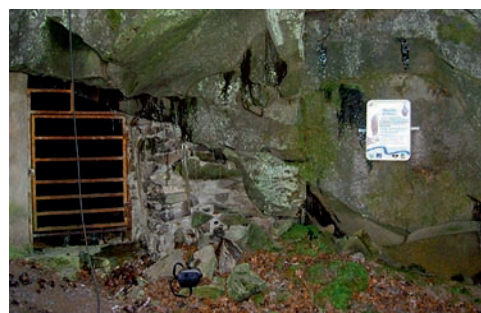
Pose d'une grille de protection d'une cavité à chauve-souris (Volvic-63) © LPO Auvergne
