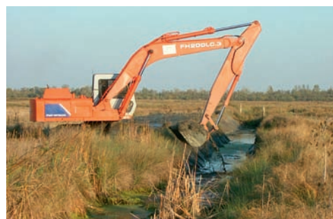
Curage d'un fossé en marais de Rochefort (17) © Christophe Egreteau/Vincent Delecour - LPO
