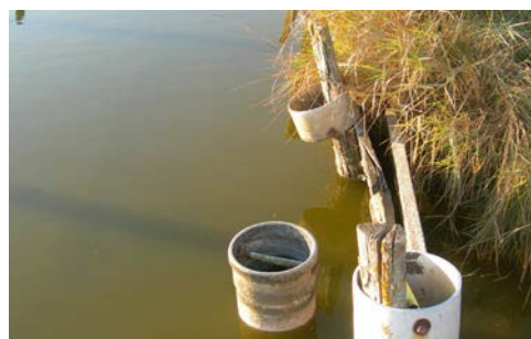
Ouvrage hydraulique de type PVC coulé avec surverse
