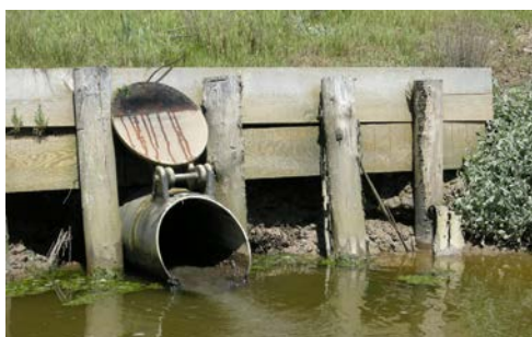
Ouvrage hydraulique de type PVC clapet anti-retour simple
