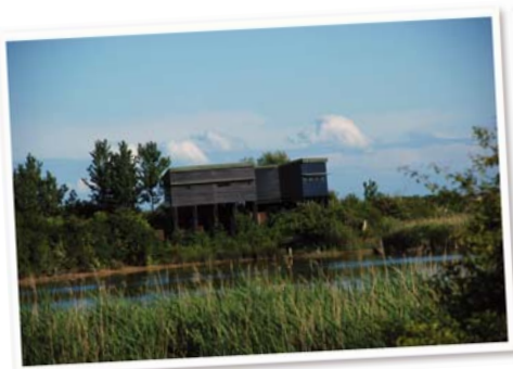
Dès 1985, le Conseil Général installe un observatoire panoramique sur les sablières, terrains dont il est propriétaire au nord de la réserve naturelle. © ML. Cayatte
