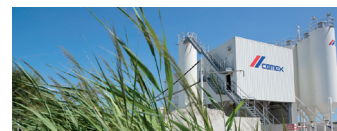
L'unité de production de bétons prêts à l'emploi de Grimaud (83).
