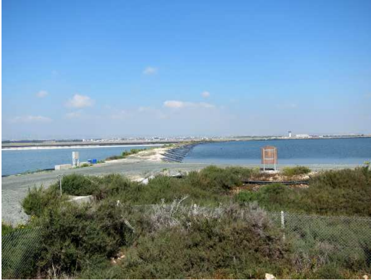
Bassins de lagunage
